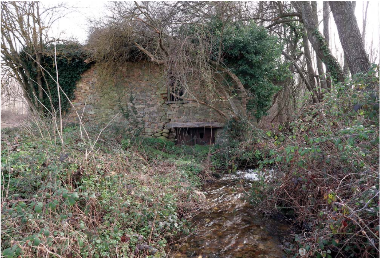
FOTOGRAFÍA 1: Vista exterior. Fachada norte. Entrada del caz al molino.
