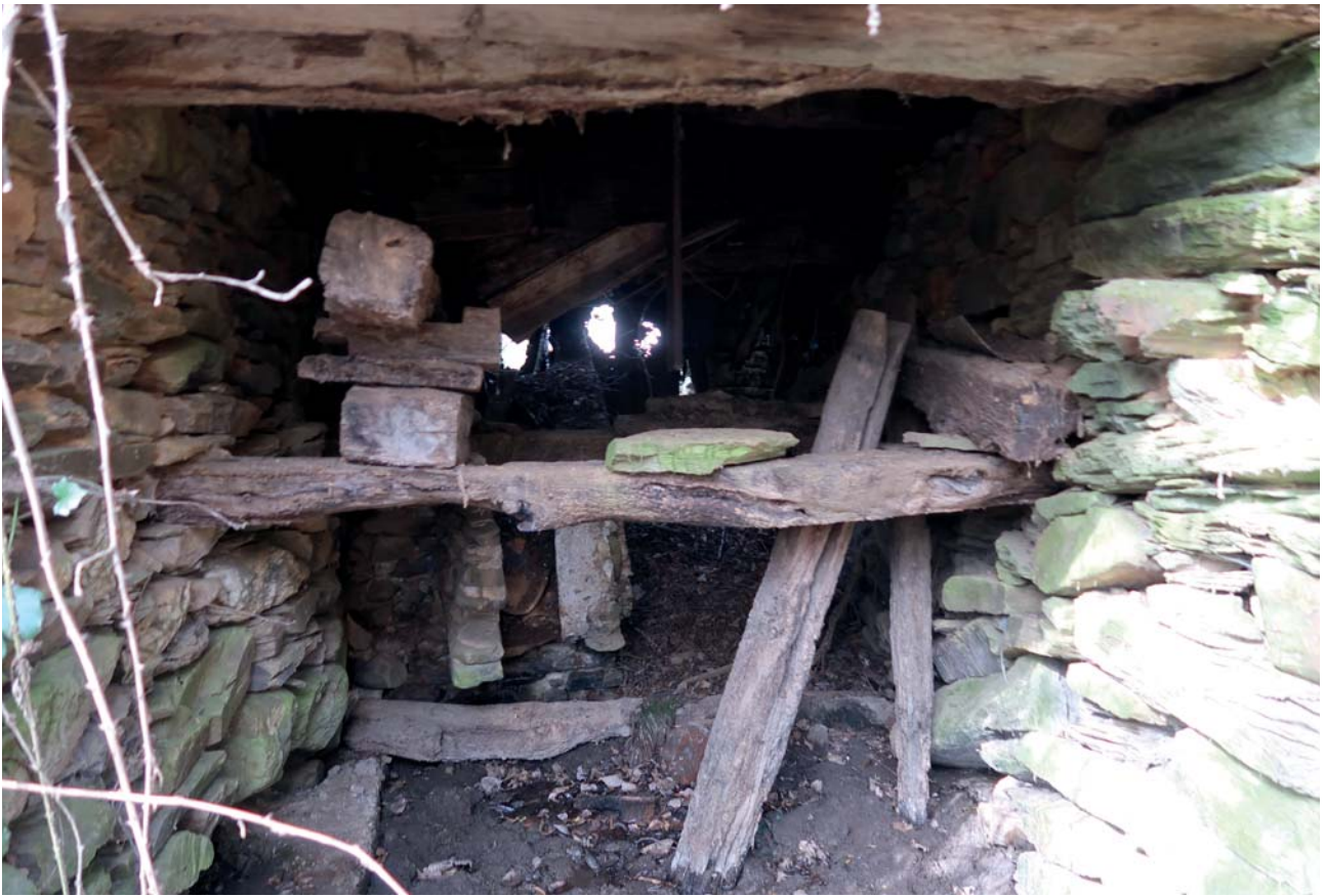
FOTOGRAFÍA 5: Vista interior del cárcavo. Restos de maquinaria del molino.
