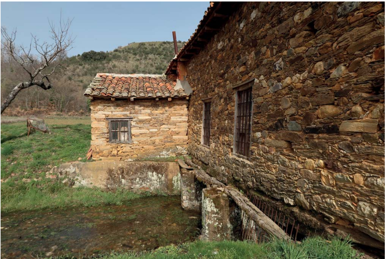
FOTOGRAFÍA 4: Vista exterior. Ampliación hacia el oeste y cárcavo.
