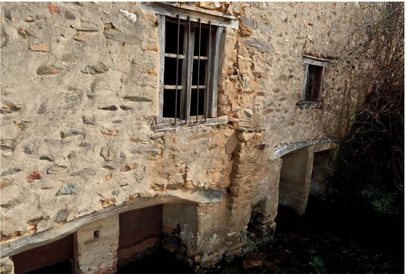
FOTOGRAFÍA 4: Vista exterior. Entrada del caz al molino.
