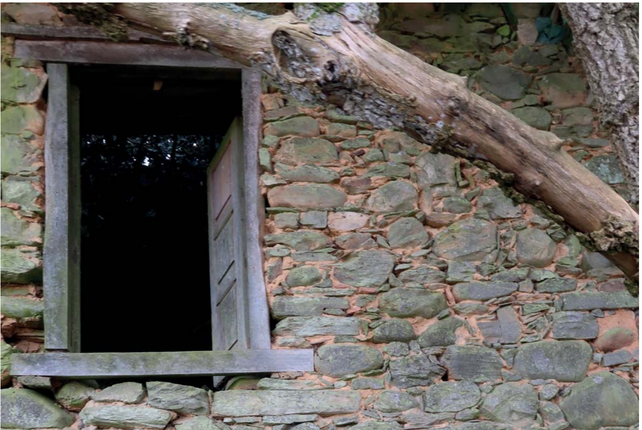
FOTOGRAFÍA 4: Vista exterior. Detalle de fachada norte.
