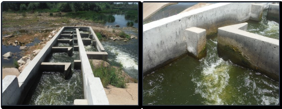
Figura 54. Vista del interior de la escala y detalle de una de las hendiduras verticales que conectan dos de sus artesas (derecha).
