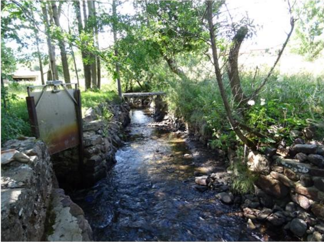
Canal de derivación del azud ES020RNF047_OBS_03 en el río Pisuerga.
