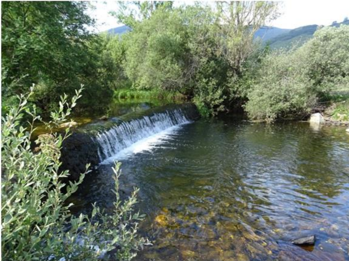
Azud ES020RNF039_OBS_03. Antigua Fábrica de Luz de Cofiñal
