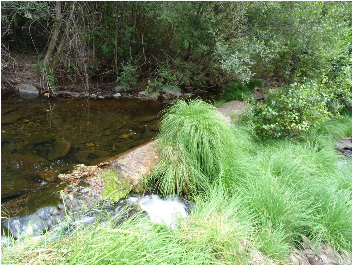
Azud para extracción de agua para regadío
