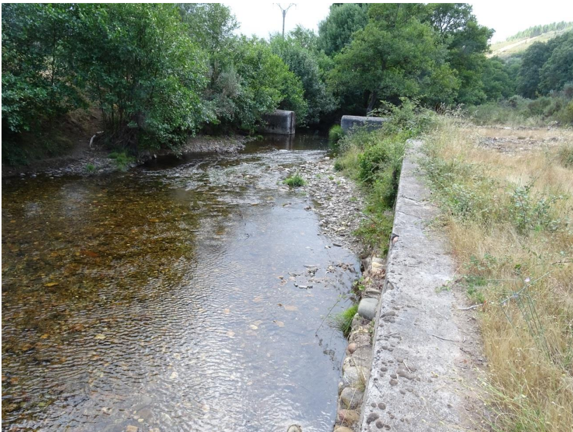
Azud y muro en el área recreativa del Bao
