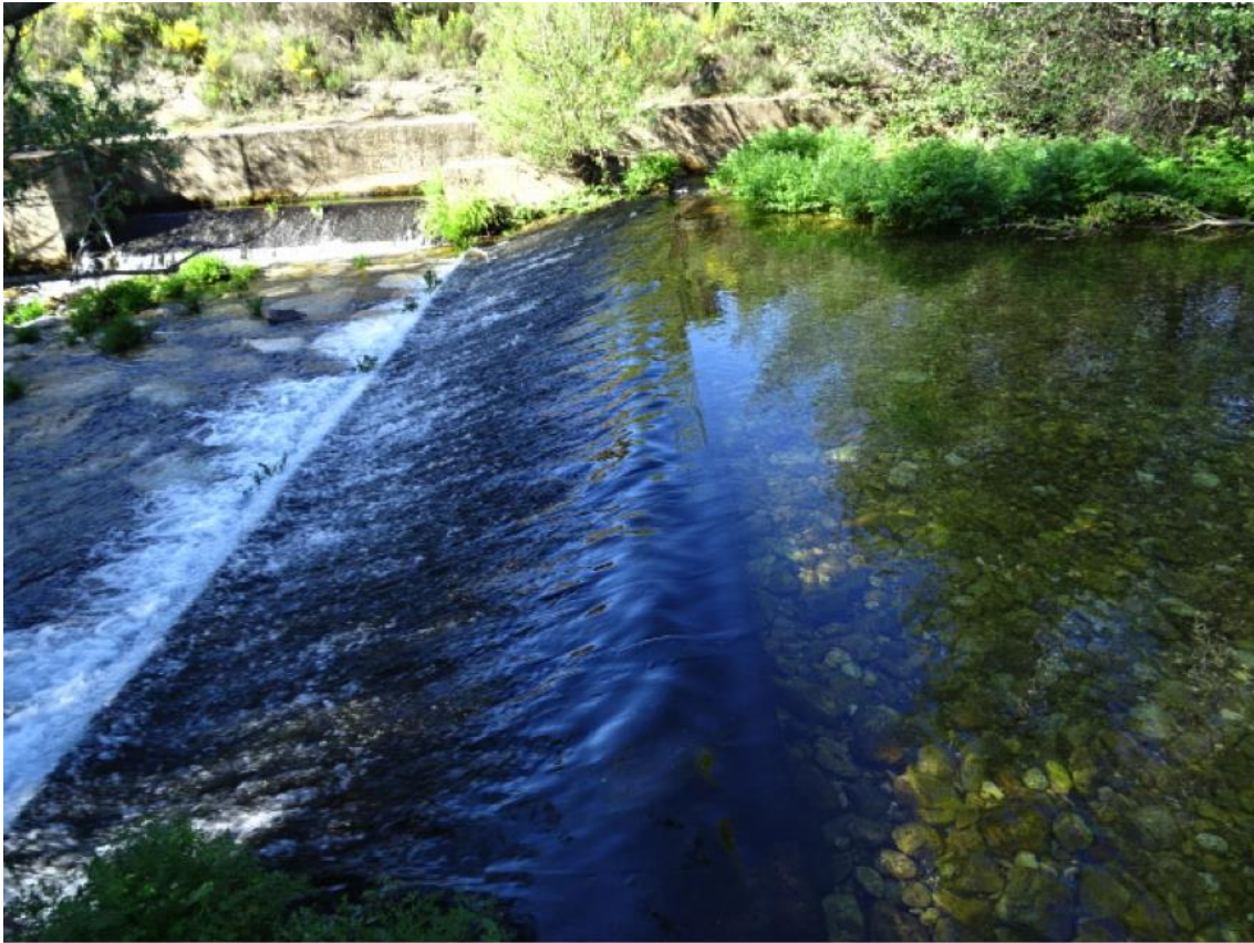
Paso sobre paramento en el río Duerna
