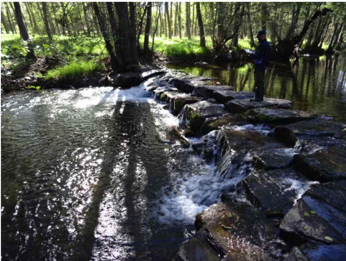
Azud para riego en el río Duerma
