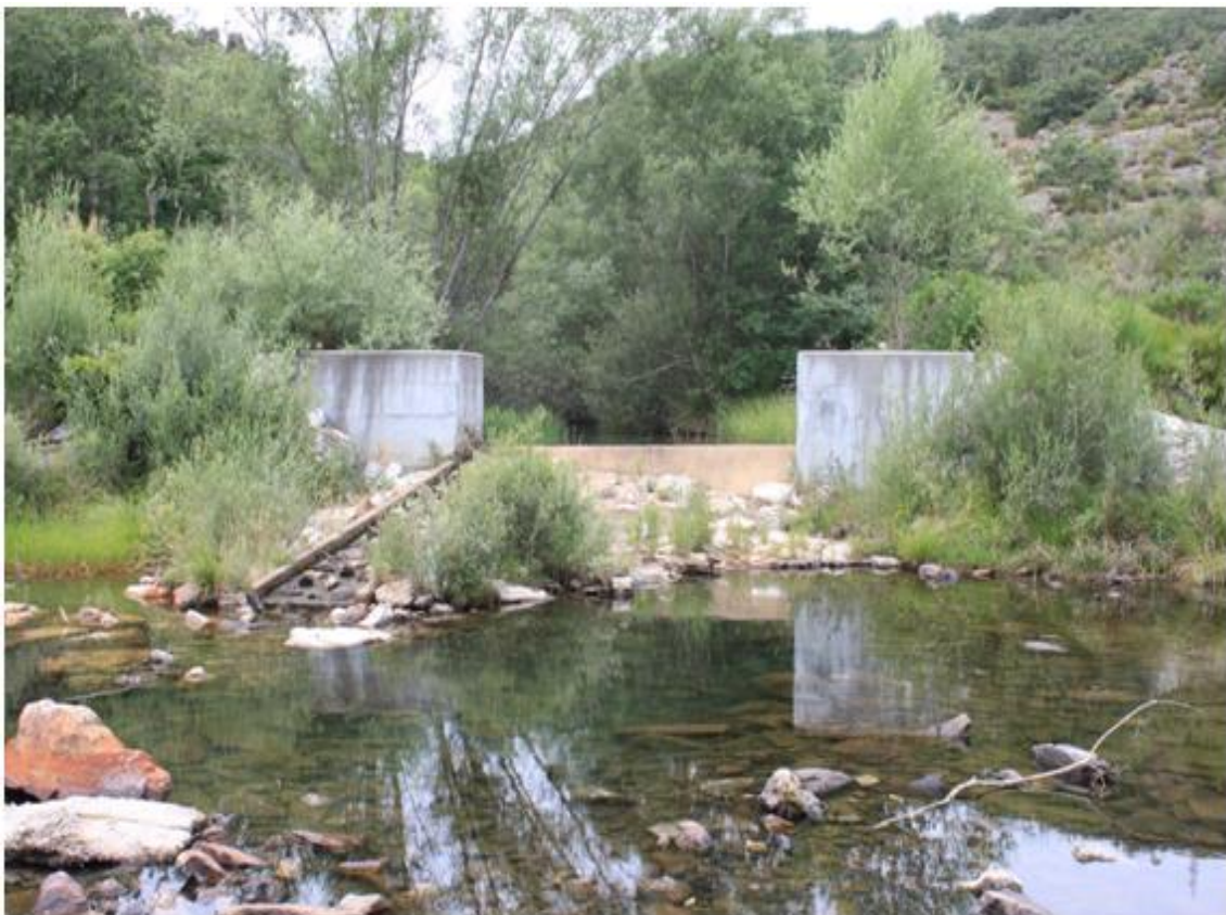
Azud 2 del Arroyo Resoba con la escala de peces no operativa.
