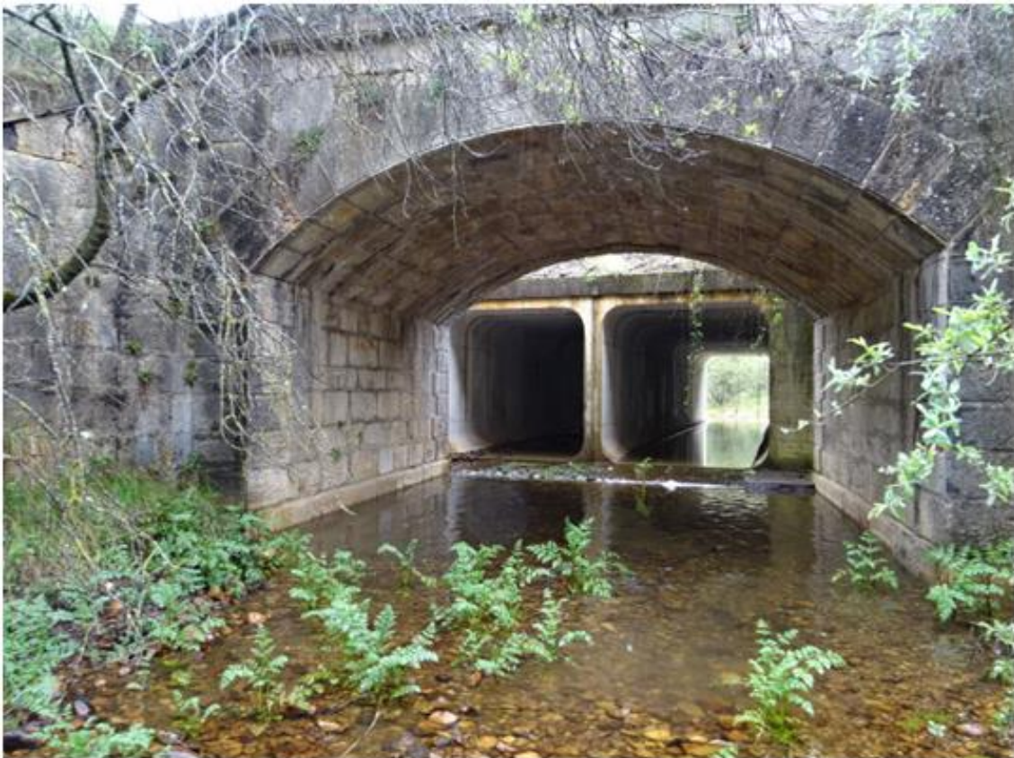
Paso entubado en la zona 2 del Arroyo Rebedul bajo la carretera LE-232
