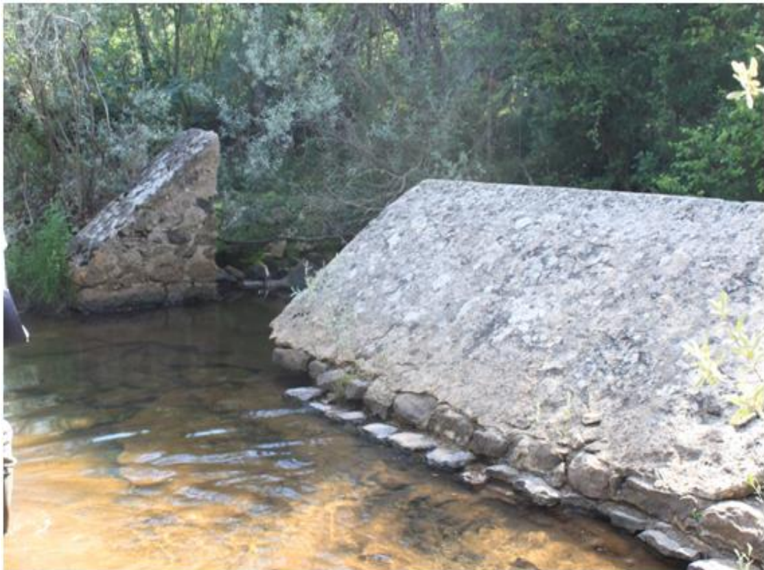
Azud en el Tramo 2. Río Razón.
