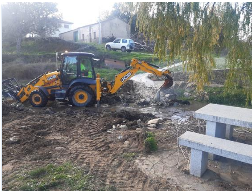
Foto 14. Demolición de un azud en el río Huebra (Salamanca). Fuente CHD
