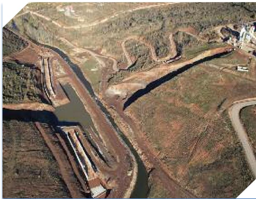
Foto 15. Vista aérea de la construcción del embalse de Castrovido
