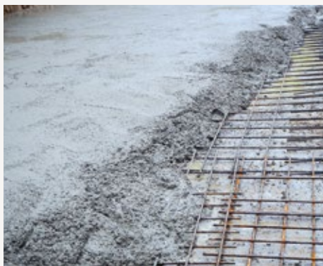
FIGURA 43 Detalle de la construcción de la base de la rampa
