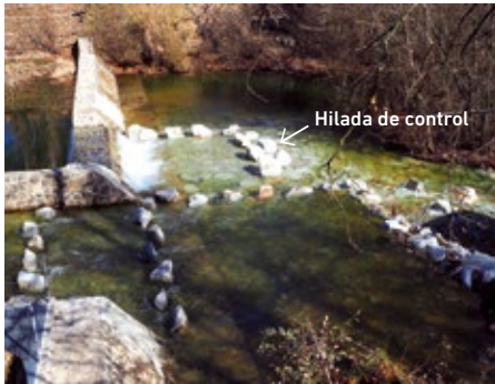
FIGURA 35. Hilada de control
