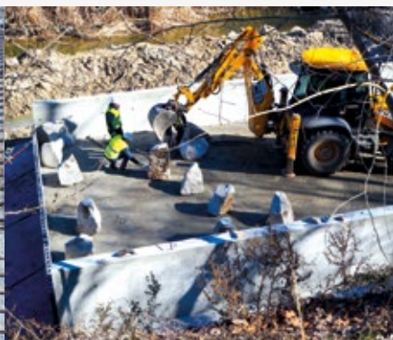
FIGURA 44 Colocación de los bolos en la rampa
