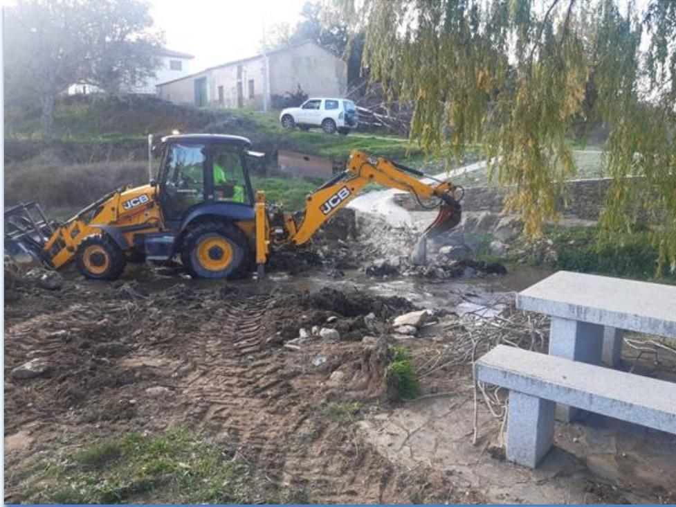
Foto 14. Demolición de un azud el río Huebra (Salamanca). Fuente CHD
