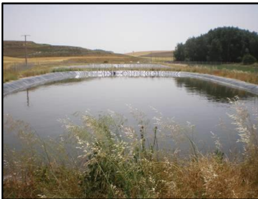
Lagunaje en Villalba de los Alcores. Autor: Área de Calidad de las Aguas de la CHD.
