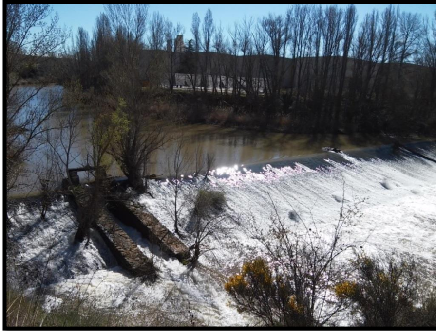
Presa de Fresnillo de las Dueñas (Burgos) en el río Duero, cuya demolición se realizó en el marco de la “Estrategia de mejora de la conectividad” en el año 2017. Autora: Verónica Orozco.
