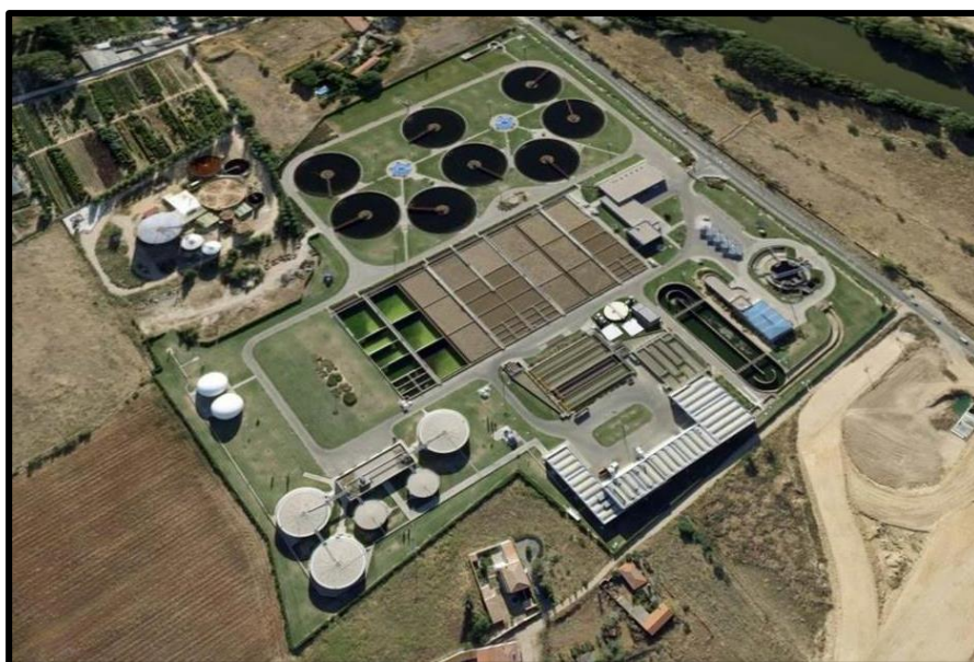
Estación depuradora de aguas residuales de Valladolid. Autor: Área de Calidad de las Aguas de la CHD.
