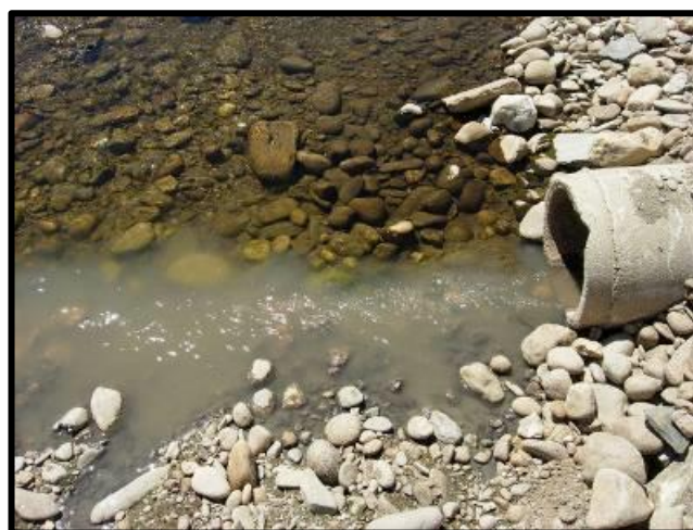
Vertido domestico sin depuración. Autor: Área de Calidad de las Aguas de la CHD.
