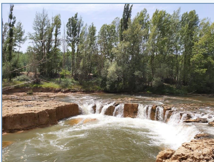
Foto 30. Grave incisión en el río Bernesga aguas abajo de León, en la foto no se aprecia ningún sedimento en el lecho del cauce pese a estar en un tramo bajo de la cuenca.
