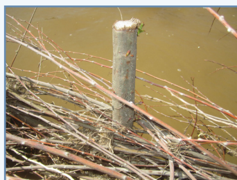
Foto 39. Estaquillado de sauce: estaquillado simple y en empalizada viva.
