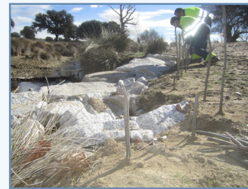
Foto 37. Fase 3: Recorte de estaquillas: corte de la parte aérea por encima de las yemas, dejando de tres a cinco yemas para asegurar el rebrote de la estaquilla.
