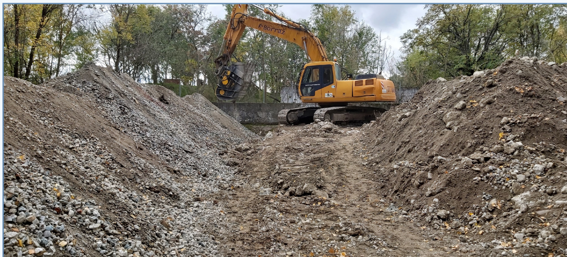
Foto 23. Machaqueo del hormigón de la antigua presa de playa de Madrid en el río Manzanares para su reutilización como árido para la reposición y mejora de los caminos del entorno.
