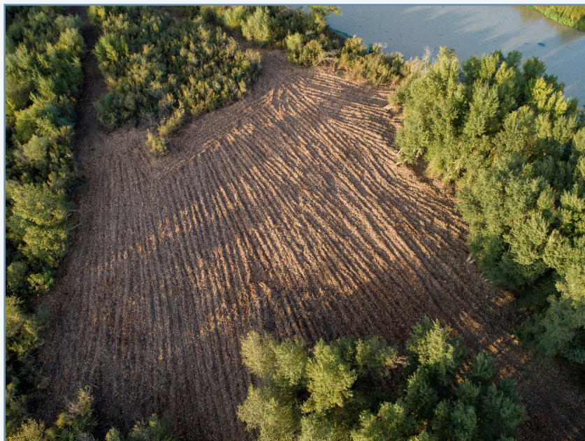
Foto 28. Vista aérea de la técnica del "curage" o labrado de sedimentos en el eje del río Ebro para permitir su movilización en episodios de crecidas.
