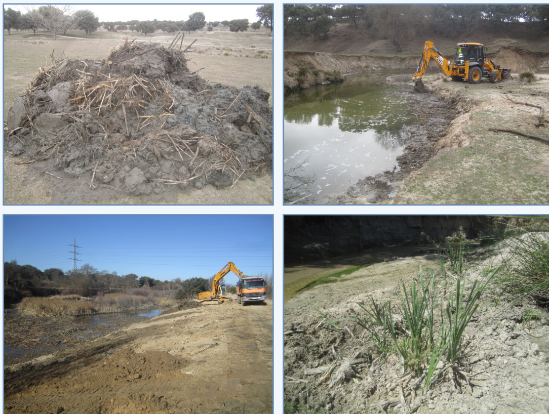
Foto 41. Fases de la restauración de márgenes con rizomas: (I) desbroce y extracción. (II) Acopio de los rizomas. (III) Extendido y regularización de la zona a restaurar. (IV) Rebrote de los helófitos en la margen restaurada.
