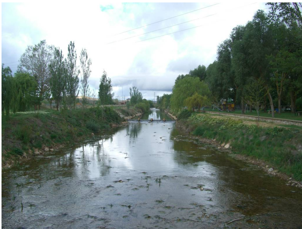
F.56.5.- Burejo en Herrera de Pisuergra. Se aprecia la rectificación del cauce.
