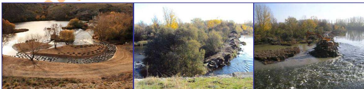
Figura 248. Ejemplos de acciones de mejora de la continuidad del cauce llevadas a cabo por la Confederación Hidrográfica del Duero en el río Tormes. Izquierda: Azud de Marín (Salamanca). Centro y derecha: demolición de un azud en el río Tormes, antes de iniciar las obras y durante las obras.
