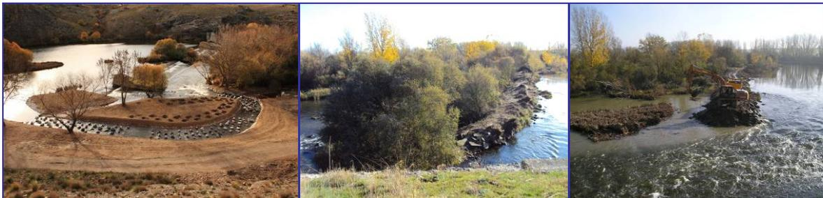
**Figura 280. Ejemplos de acciones de mejora de la continuidad del cauce llevadas a cabo por la Confederación Hidrográfica del Duero en el río Tormes. Izquierda: Azud de Marín (Salamanca). Centro y derecha: demolición de un azud en el río Tormes, antes de iniciar las obras y durante las obras.**
