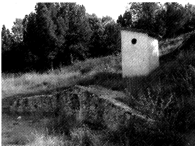
Manantial de abastecimiento a Blacos
