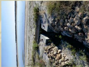
Arqueta de desagüe de la laguna principal en el arroyo del Molino.
