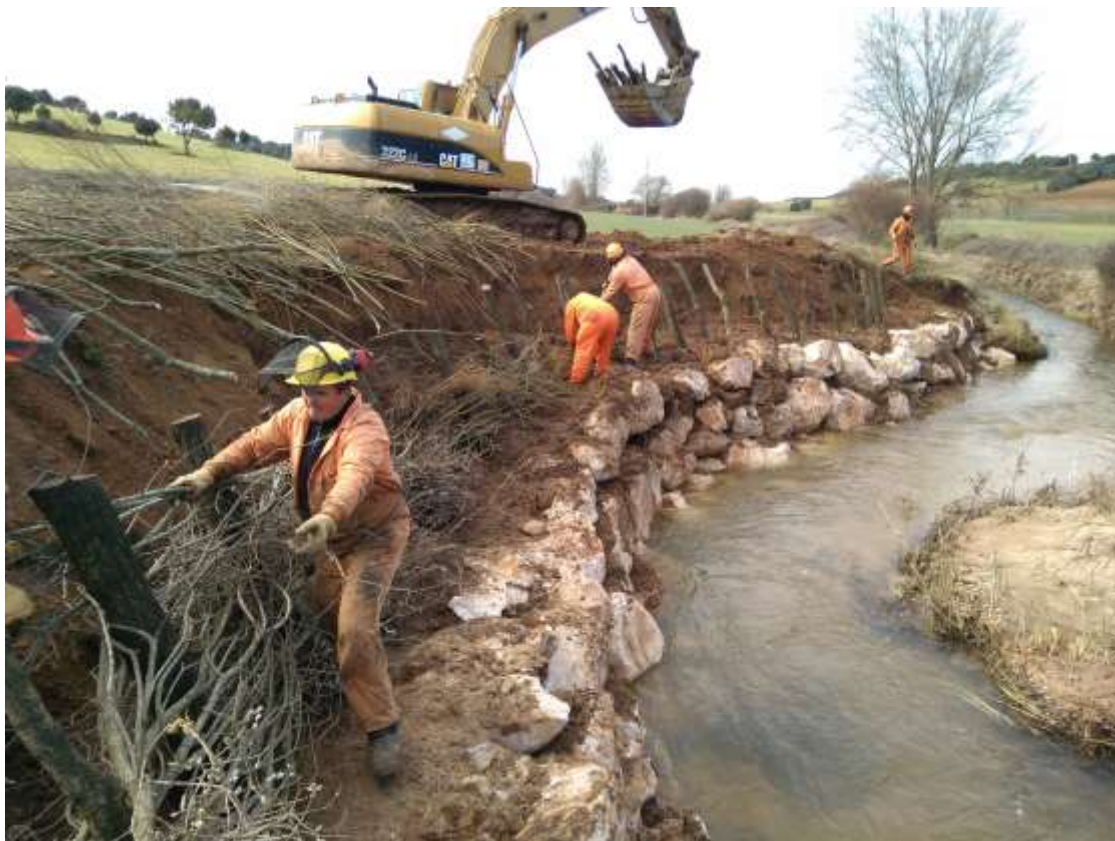
Imagen de construcción de una escollera en el río Pilde (Archivo)
