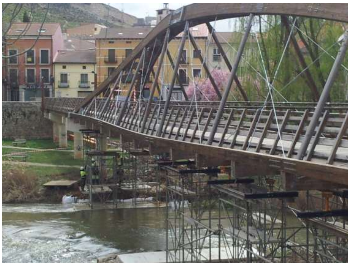
Imagen actual del andamiaje temporal instalado.
