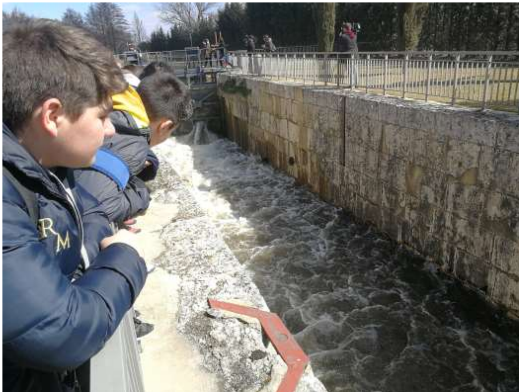
Escolares observan la maniobra de llenado de la esclusa del Canal de Castilla.
