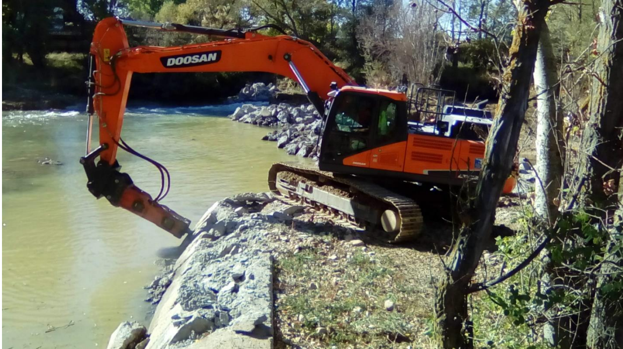
Figura 17. Obras de demolición de la traviesa 29, situada en la coordenada longitudinal s = 11.8 km.
