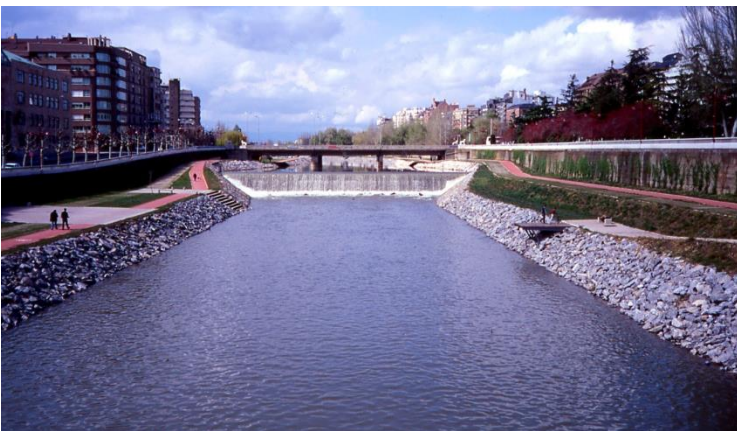
Figura 4. Azud de la central hidroeléctrica en León, 1-X-2018 (arriba). Vista aguas abajo y aguas arriba del azud en 2006 antes de ser convertido en aprovechamiento hidroeléctrico (abajo). Ver Tabla 3 para la coordenada longitudinal donde se sitúa.
