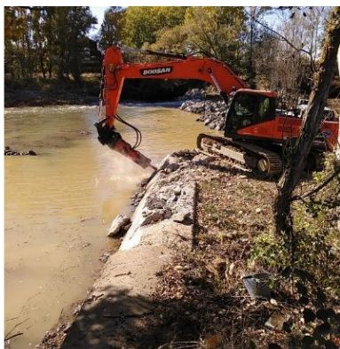
Figura 88. (Izquierda) Foto de la demolición de traviesa en curso aguas abajo de la confluencia con el Torío, el 25-X-2019. (Derecha) Detalle del perfil longitudinal de la zona de traviesas: las líneas medias (negras) tienen contrapendiente.
