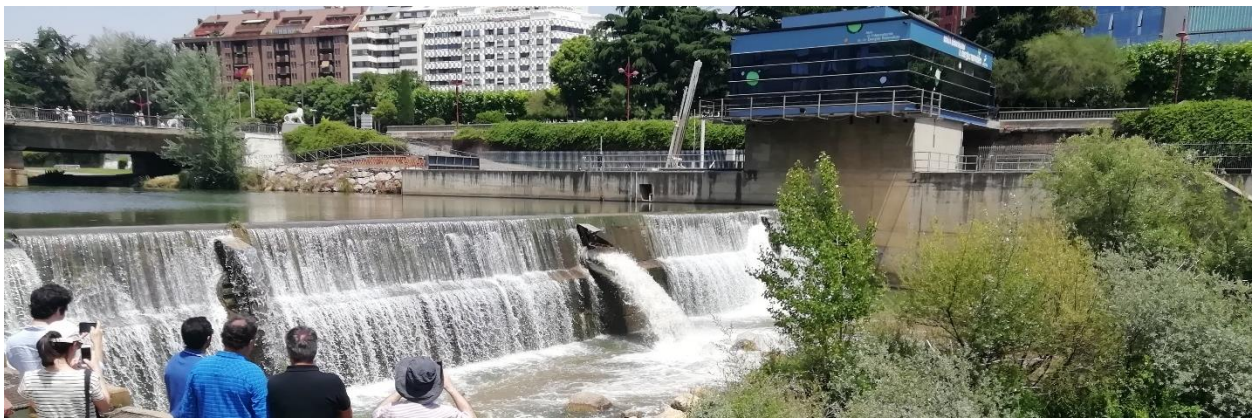
Figura 87. Vista desde la margen derecha de la apertura de un desagüe de fondo en el azud de la central hidroeléctrica. Fotografía tomada el día 27 de junio de 2019.
