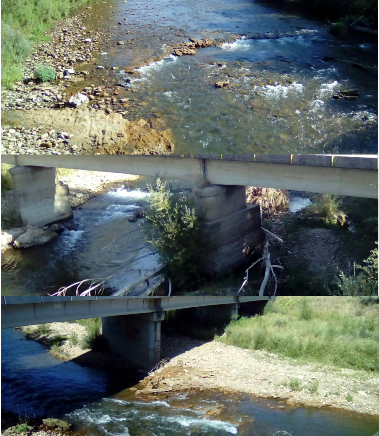
Figura 8. Vista hacia aguas arriba desde el puente de histórico de Carbajal de la Legua (arriba); del mismo puente (centro) y del puente nuevo sobre la carretera LE-5504 (abajo), visto desde el puente histórico.
