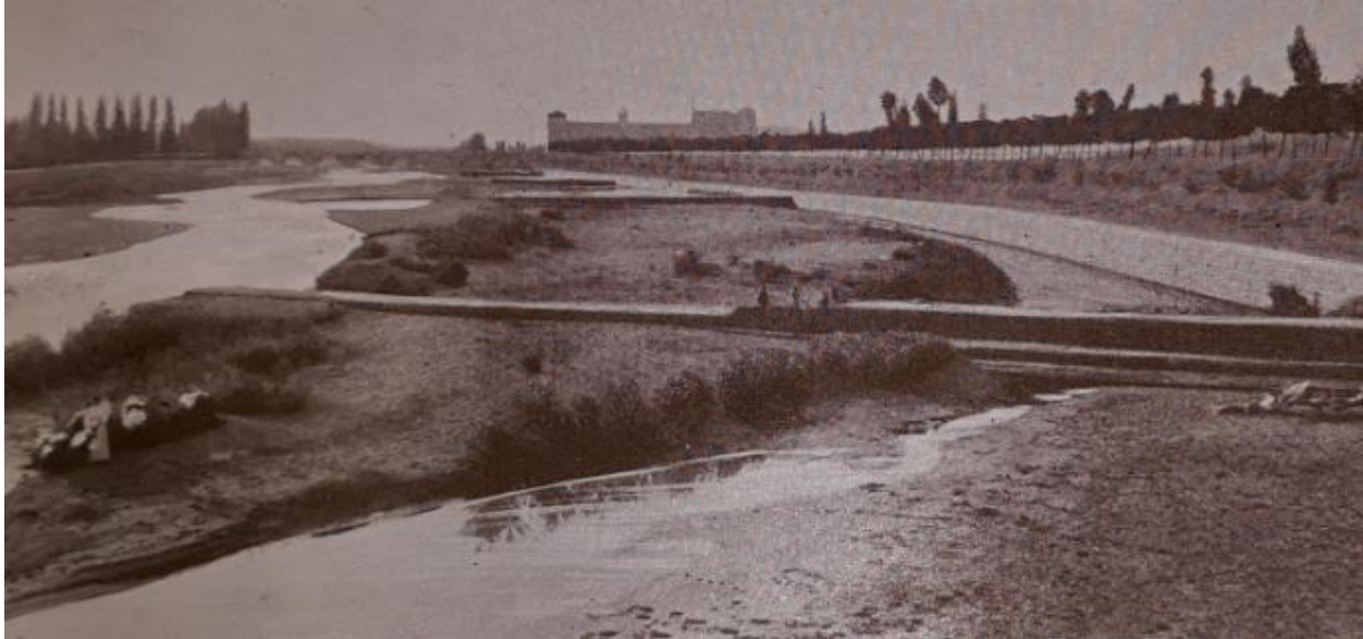
Figura 36. Vista hacia aguas arriba de los espigones orientados ligeramente hacia aguas arriba que arrancan desde la margen izquierda del cauce (derecha de la imagen). Al fondo a la derecha de la imagen el hospital de San Marcos y el puente homónimo. Fuente: Catálogo de defensas fluviales (A. Bianchini, Ingenieros S.A., Barcelona).
