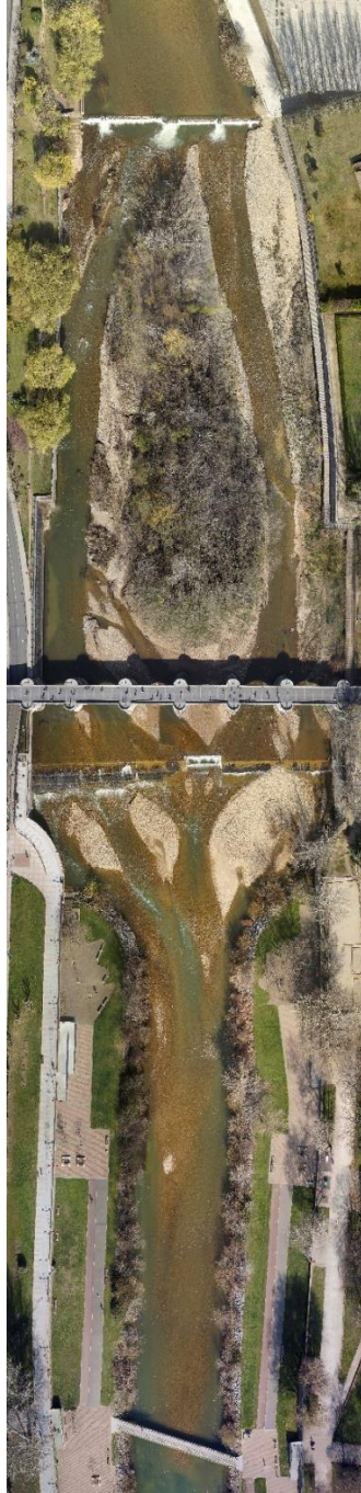
Figura 74. Fotografía aérea tomada con dron el día 23 de abril de 2014, poco después de la demolición del azud. Obsérvese el depósito de material al pie del azud parcialmente retirado.
