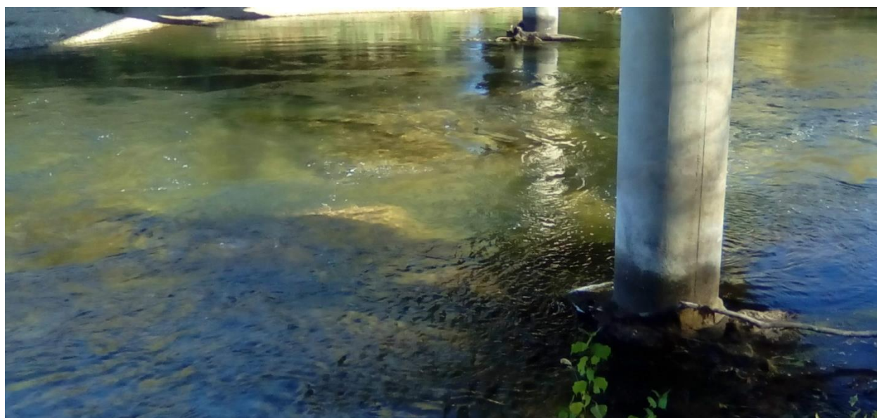
Figura 27. Pilas del puente de la carretera LE-5516 sobre el río Esla en Villaroañe (T.M. de Villaturiel). Obsérvense las formaciones rocosas, de naturaleza irregular, muy parecidas a las presentes en muchos tramos del río Bernesga (Figura 23).
