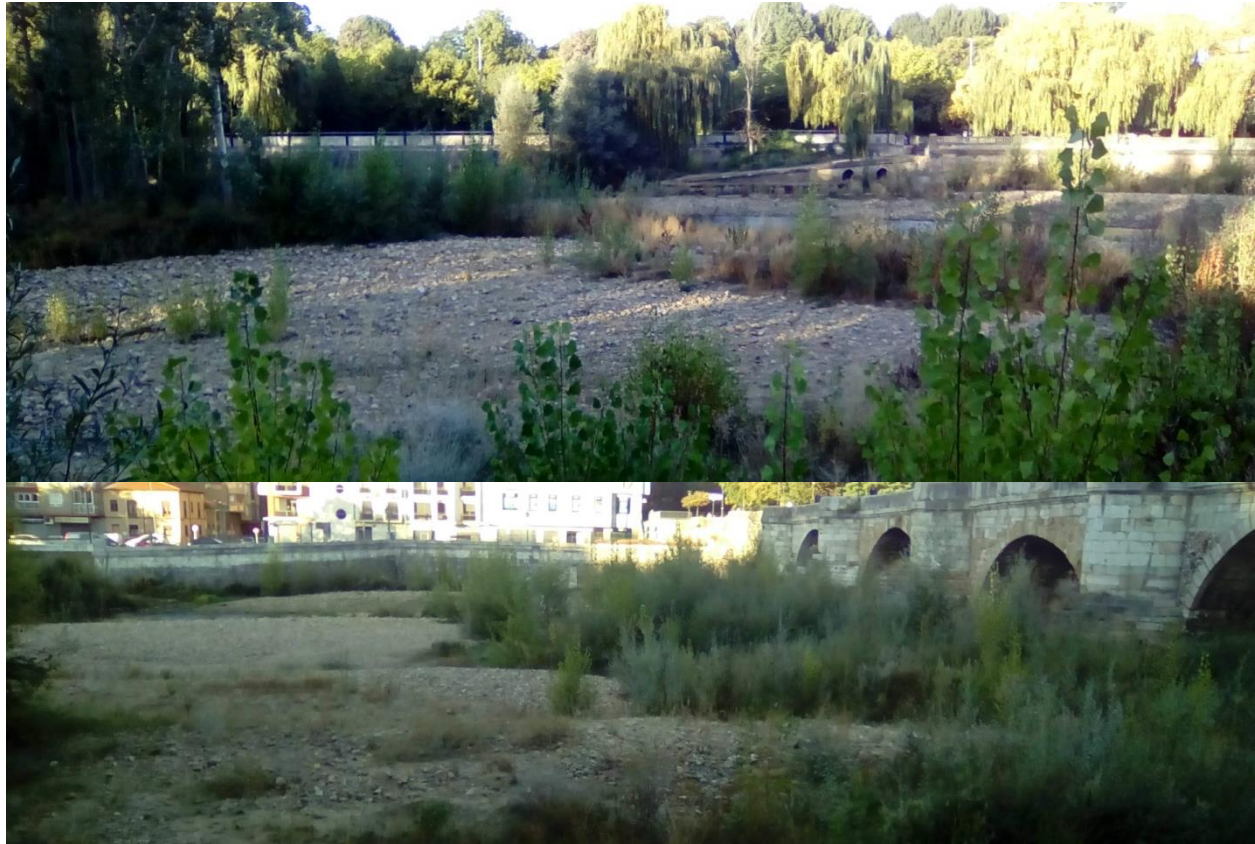
Figura 12. Vistas desde la margen izquierda de los depósitos de material aluvial aguas arriba (foto superior) y aguas abajo del puente de San Marcos (foto inferior). La imagen superior pertenece a un punto situado unos 220 m aguas arriba del puente.
