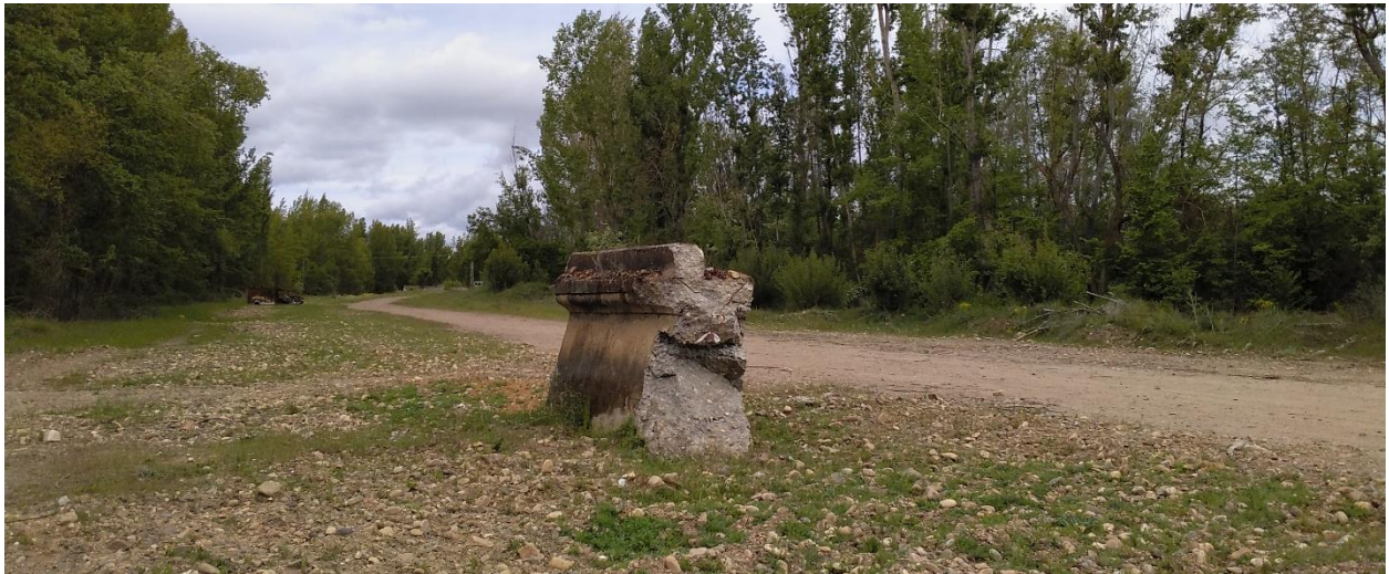
Figura 89. Muro de 1983 demolido en la llanura izquierda del Bernesga (arriba) y fragmento conservado como testigo de la demolición (abajo). Fotos 10-V-2019.
