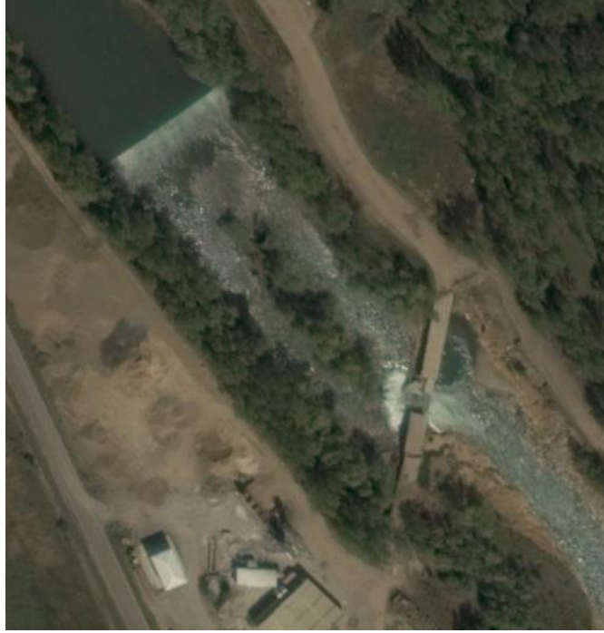
Figura 18. Fotografía aérea del colapso parcial del vado. Fecha de la imagen: 20 de abril de 2015. Imagen tomada de Google Earth.
