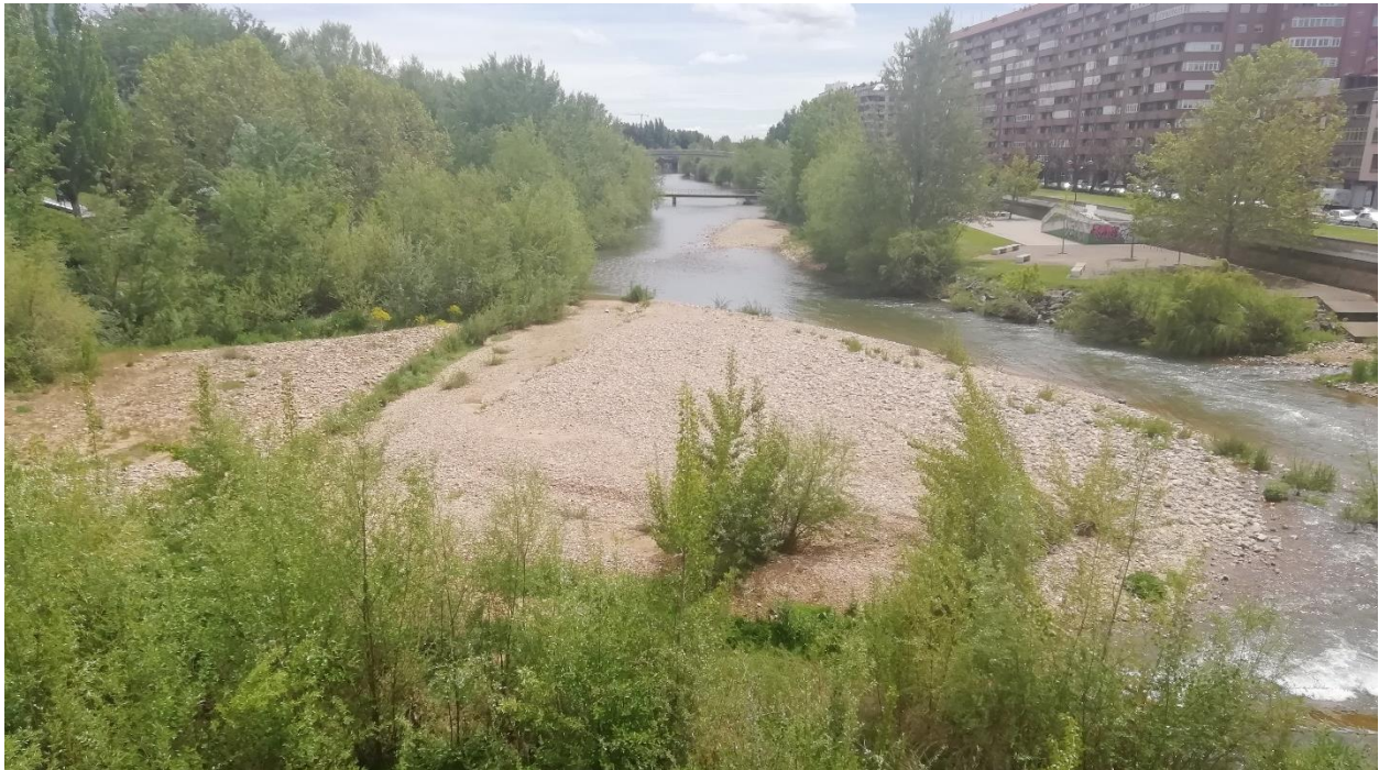
Figura 78. Vista del Bernesga des del puente de San Marcos hacia aguas abajo. Obsérvense los grandes depósitos de material entre el puente de San Marcos y la pasarela 5 al fondo.
