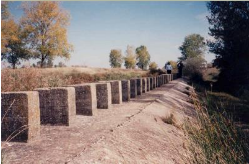
Figura 8. Derrame de Abánades (Burgos).
