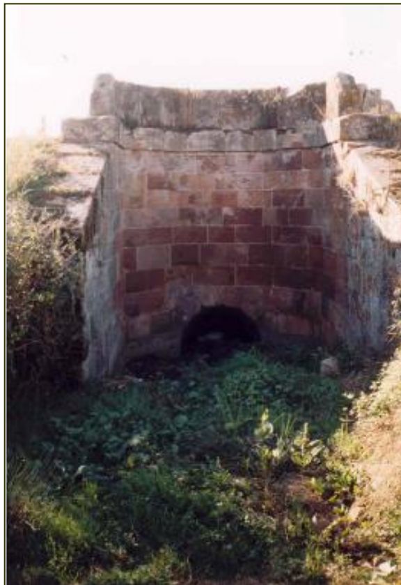
Figura 5. Alcantarilla de Conejera (Palencia)
