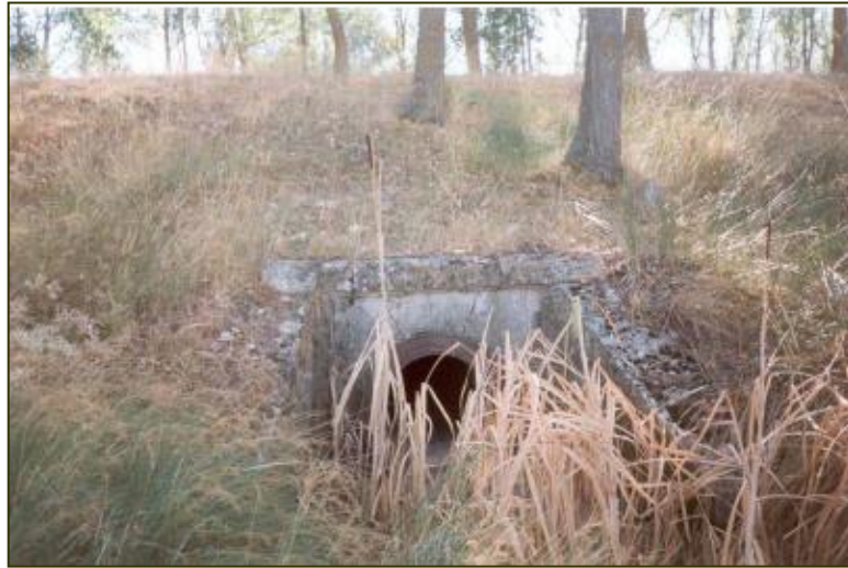
Figura 4. Alcantarilla del Arroyal (Palencia)
