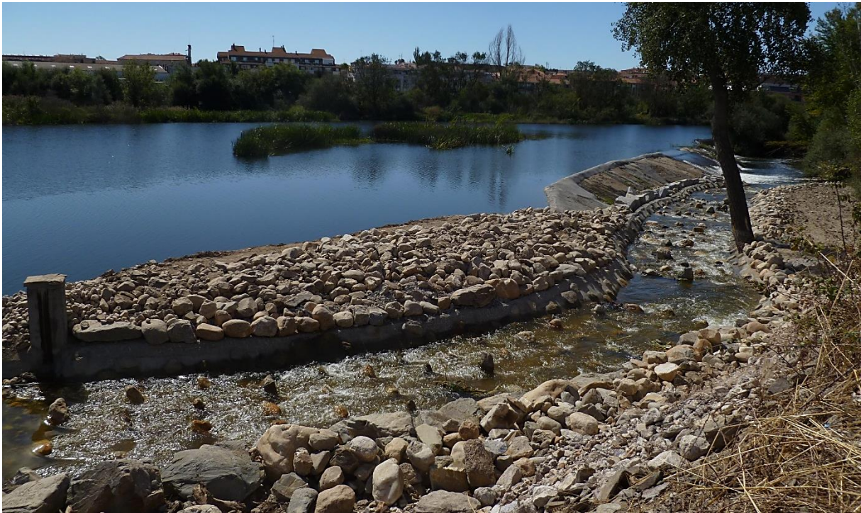
FIGURA 2. EJEMPLO DE PASO PARA PECES (TIPO RÍO ARTIFICIAL CON BLOQUES DE GRAN TAMAÑO) ADOSADO A UN AZUD EN EL RÍO TORMES (LEDESMA, SALAMANCA).
