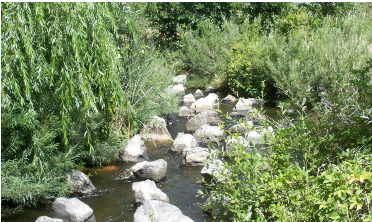
FIGURA 36. RÍO ARTIFICIAL DE BLOQUES, RÍO TORMES (AZUD EL MARÍN, SALAMANCA).
