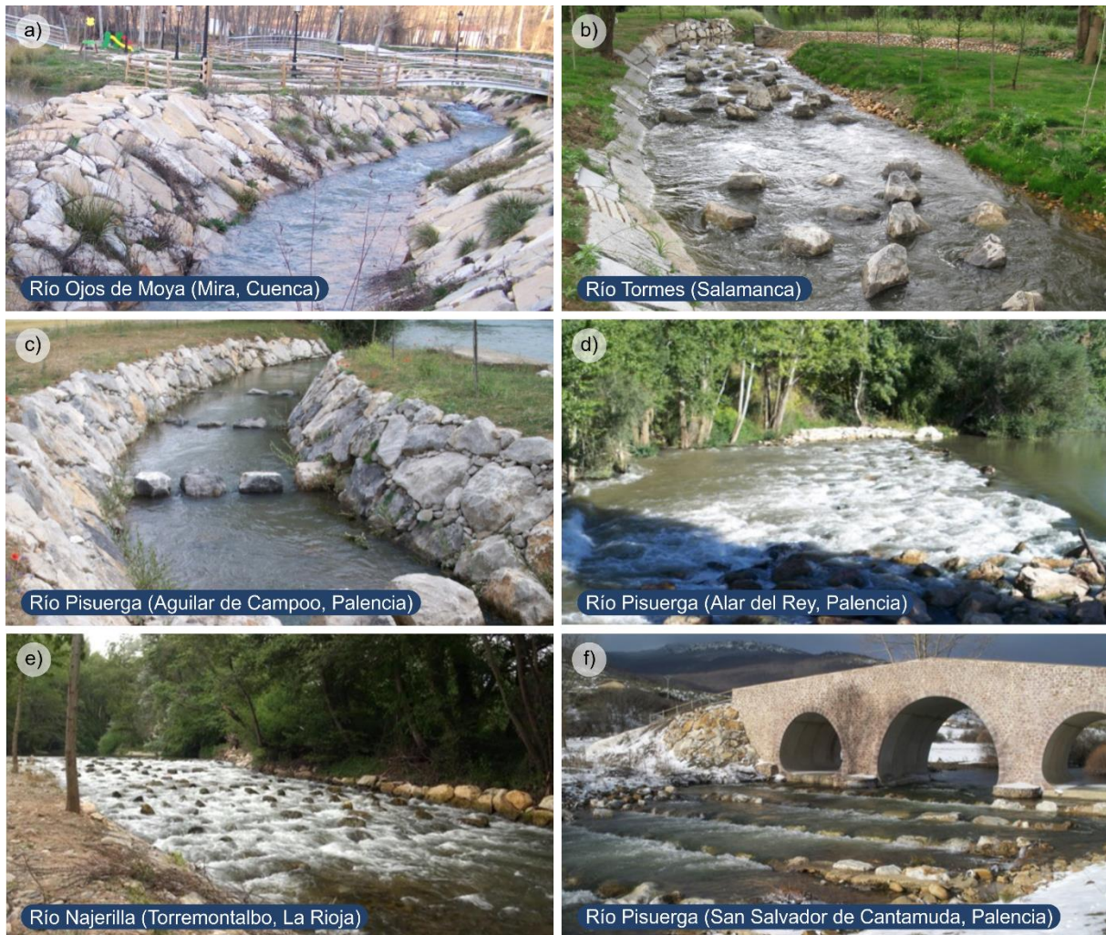
FIGURA 4. DIFERENTES EJEMPLOS Y TIPOLOGÍAS DE PASOS NATURALIZADOS. a) RÍO ARTIFICIAL DE RUGOSIDAD UNIFORME. b) RÍO ARTIFICIAL CON BLOQUES DE GRAN TAMAÑO. c) RÍO ARTIFICIAL TIPO RÁPIDO-REMANSO. d) RAMPA DE RUGOSIDAD UNIFORME. e) RAMPA CON BLOQUES DE GRAN TAMAÑO. f) RAMPA TIPO RÁPIDO-REMANSO. EN OCASIONES, EL EXCESO DE ESCOLLERA EN LOS TALUDES DE ORILLA PROVOCA UN EFECTO ESTÉTICO NO DESEADO. SE RECOMIENDAN TÉCNICAS DE ESTABILIZACIÓN BASADAS EN BIOINGENIERÍA SIEMPRE QUE SEA POSIBLE.
