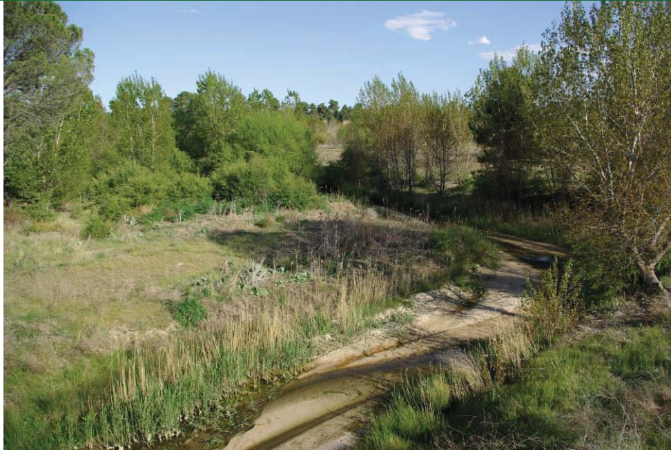
F.19.14.- Arevalillo en puente de Nava de Arévalo.
